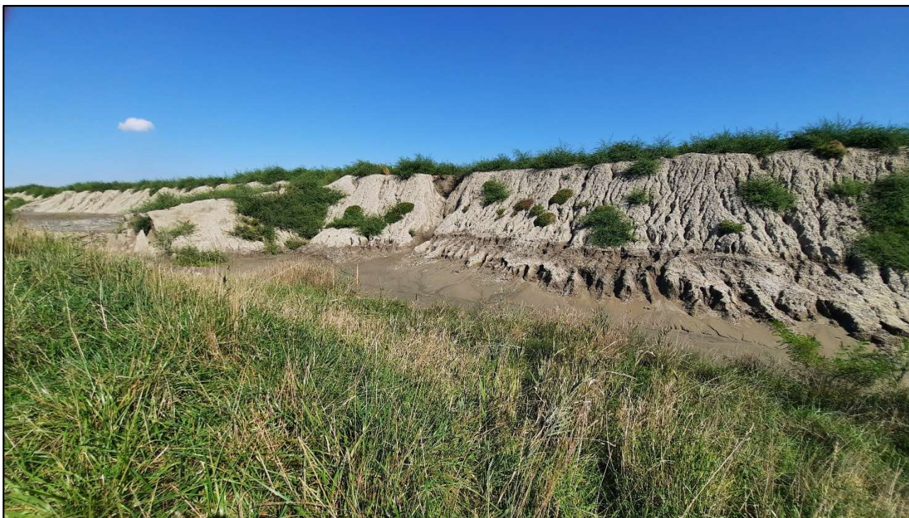
Figura 11 - Comune di Porto Viro – località Ca' Cappello – Destra idrografica del Po di Levante – Materiale terroso disponibile per il rialzo arginale già interessato da precedente movimentazione.
